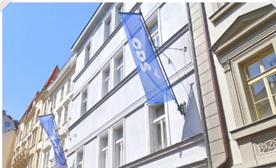
Sídlo Hlavní kanceláře ODS v Truhlářské ulici na Praze 1
