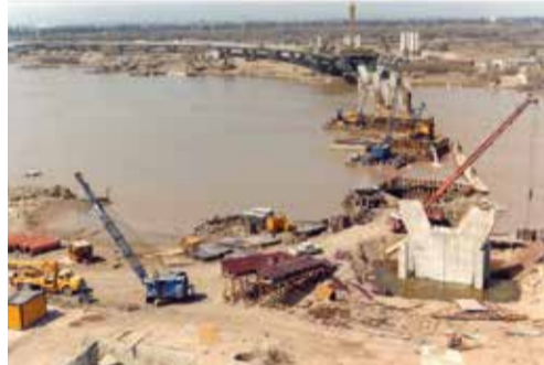
Výstavba mostu Jadiryah v Bagdádu (foto z archivu Ing. Vladimíra Tvrzníka)
