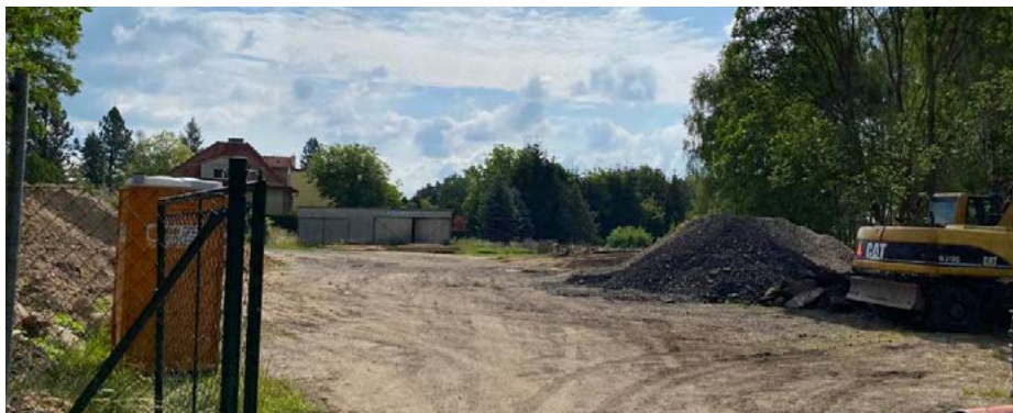
Zde mohlo stát multifunkční hřiště. Místo toho je tu deponie stavebního materiálu, odpadu a parkoviště strojů.
